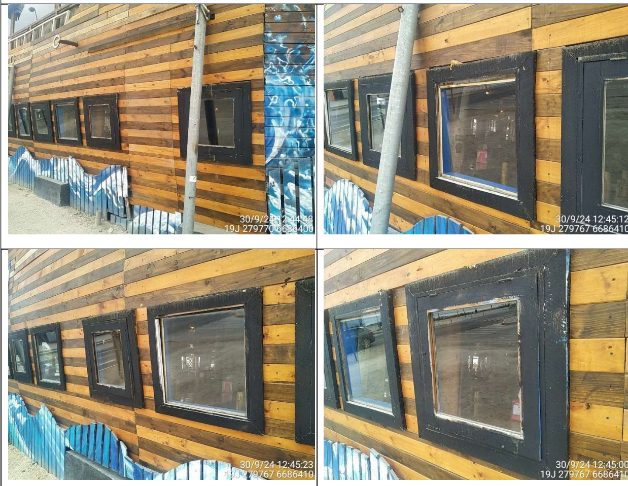
Vista exterior de la fachada sur, 30 de septiembre de 2024.
