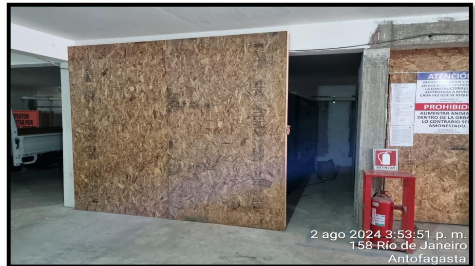
**ANEXO N°5 (ACTUALIZADO) FABRICACIÓN E INSTALACIÓN DE PANELES ACÚSTICOS PARA GENERADOR ELÉCTRICO**
