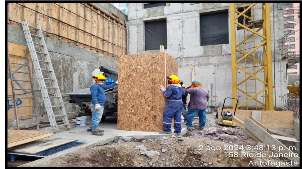
**ANEXO N°4 ( ACTUALIZADO) FABRICACIÓN E INSTALACIÓN DE PANELES ACÚSTICOS PARA BOMBA DE HORMIGÓN**
