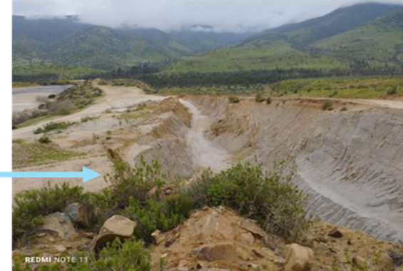
Fotografía sección ya construida canal de evacuación sur oriente
