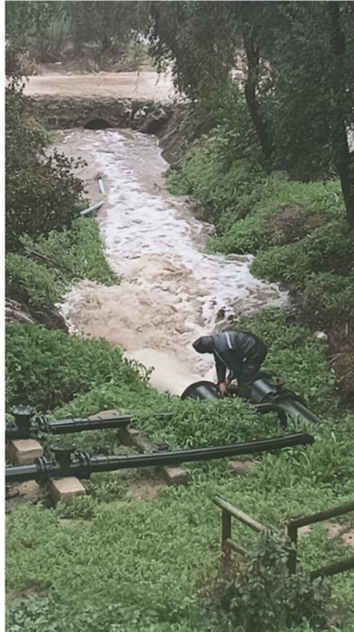
Figura 6. Evacuación de aguas de la quebrada El Trébol para restitución a su cauce natural.
