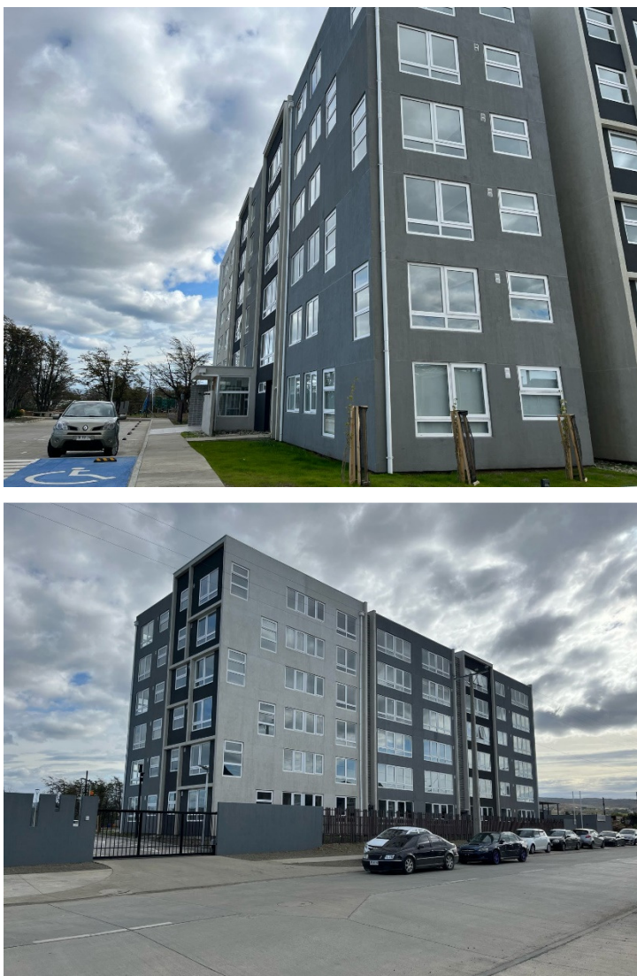
Figura 1: Imágenes que dan cuenta del edificio finalizado
