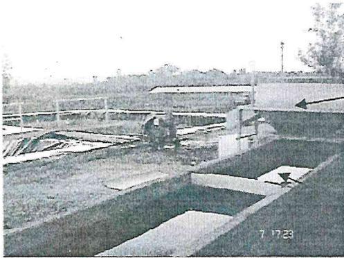
Filtro parabólico que separa los sólidos que llegan desde las cámaras de canalización al interior de la bodega
