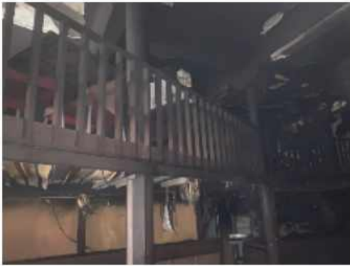
Imagen 5: vista de interior de local
