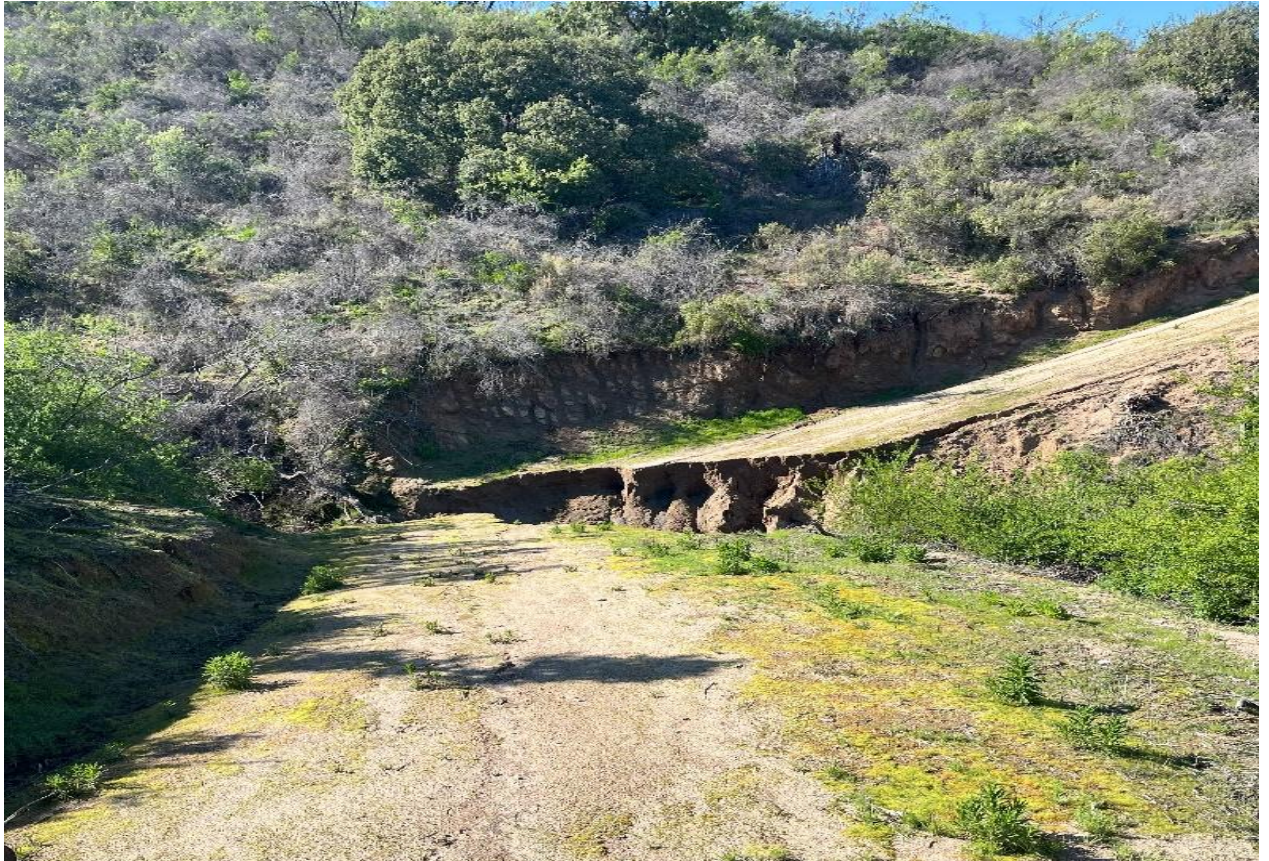
Camino cortado sector el Bosco, gran socavón, daño e intervención a la quebrada
