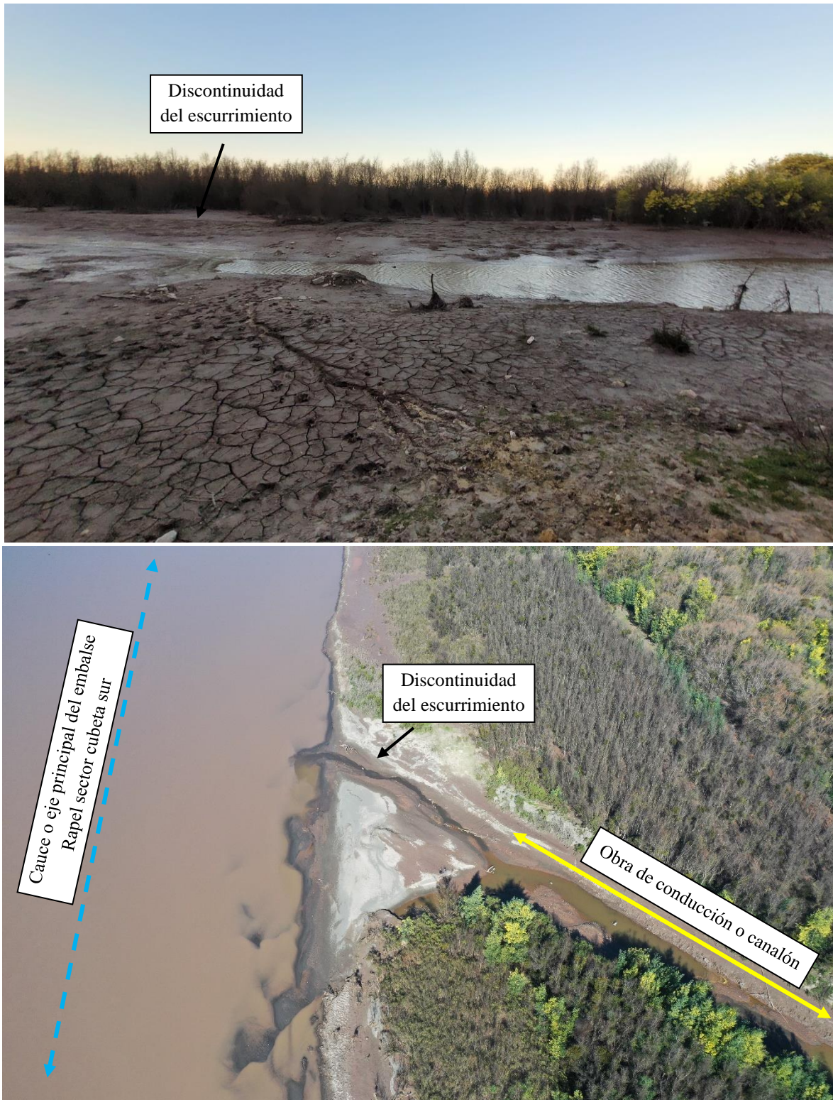
Figura 3-4. Discontinuidades en el escurrimiento. Arriba: extremo de aguas abajo indicada como “Discontinuidad” en Figura 3-3. Abajo: discontinuidad del escurrimiento al interior de obra de conducción sector eje principal de la cubeta sur del embalse Rapel.
