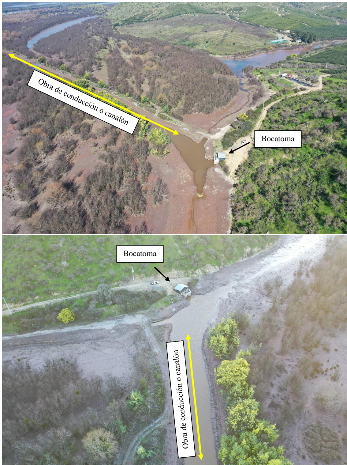
Figura 2-4. Fotografías aéreas que muestran obra de conducción de aguas o canalón, y el sector de emplazamiento de las obras de bocatoma.
