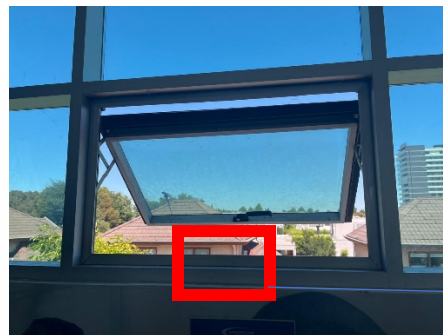
Imagen 8: Sistema de cierre para impedir apertura
