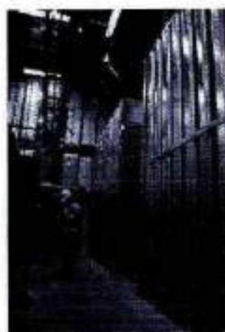
Atenuadores de ruido tipo splitter en sala de grupo electrógeno. Data Center SONDA, Santiago.
