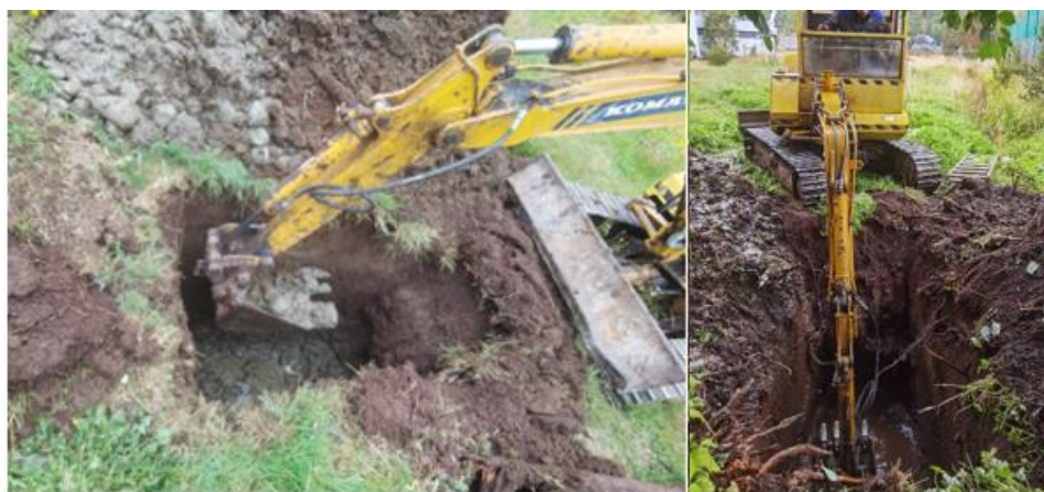
Figura 5: proceso de realizado de calicatas con la ayuda de miniexcavadora.
