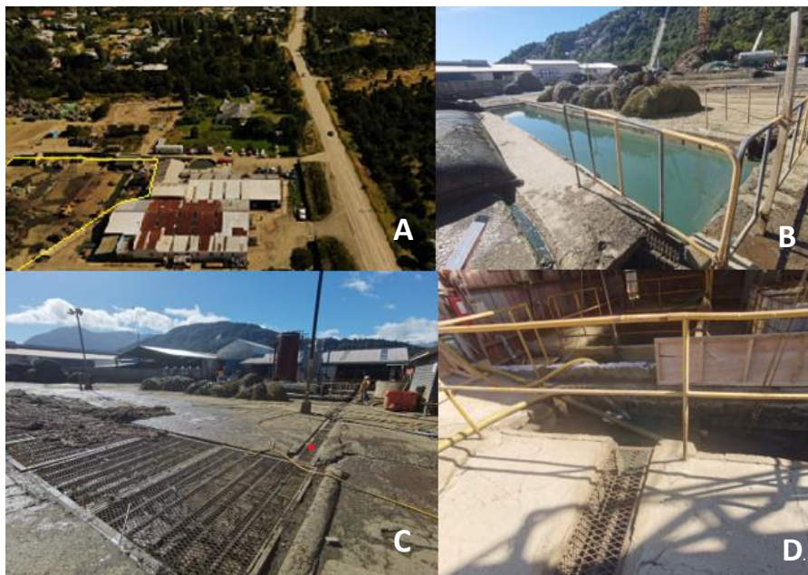
Figura 2: (A) Vista aérea de la Empresa; (B) Piscina de recepción del ril, proveniente de proceso de lavado y de las aguas lluvias de contrato, detrás zona de acopio de mallas; (C) Zona de hidrolavado, vista de filtros de residuos sólidos; (D) Zona contigua a planta de tratamiento, sector de acumulación de agua.
