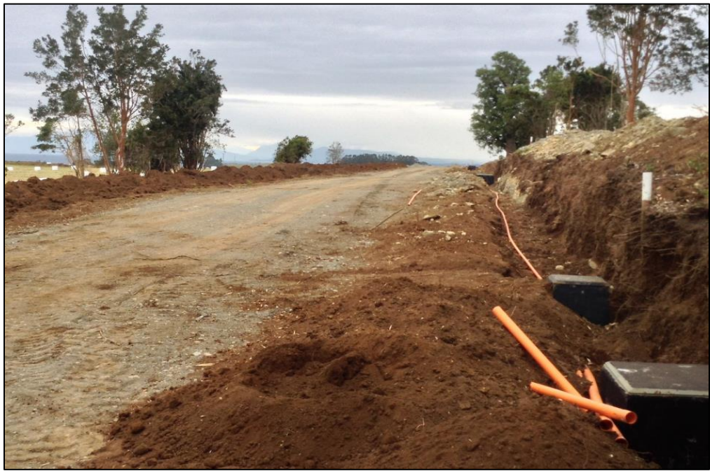
Imagen N° 1: Trazado subterráneo de electricidad del Proyecto
