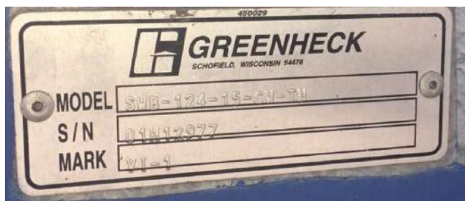
Imagen 2: Placa Ventilador Inyección aire fresco
