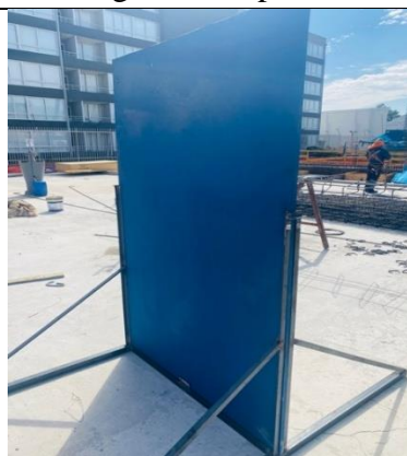
Fotografías de paneles acústicos para corte de metal en patio de enfierradura
