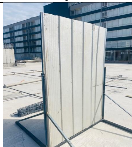
Fotografías de paneles acústicos para corte de metal en patio de enfierradura
