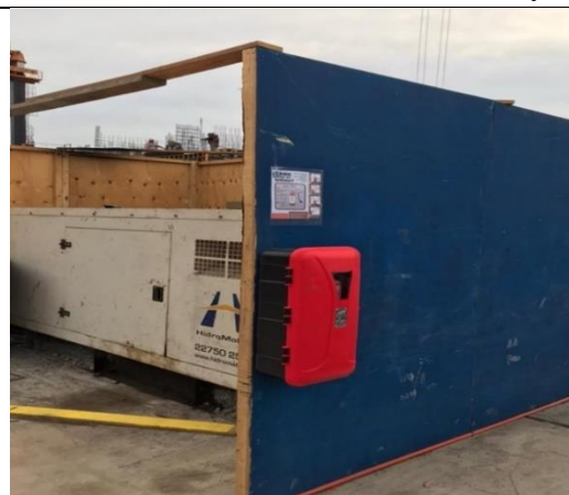
Fotografías de panel acústico de OSB 15 mm en andamio fachada calle 3 de mayo
