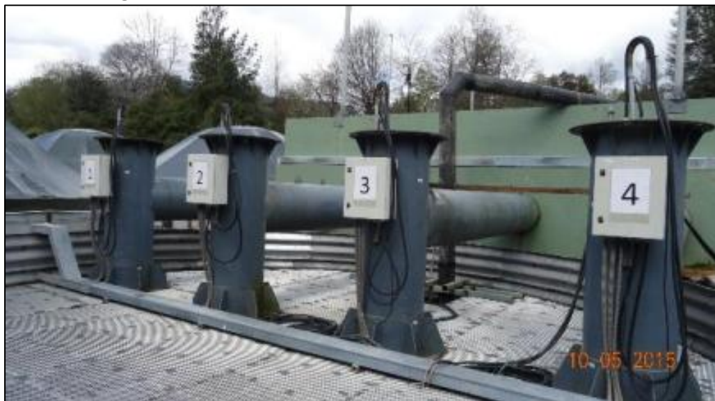
Imagen N° 11: Bombas utilizadas en sector de bocatoma.
