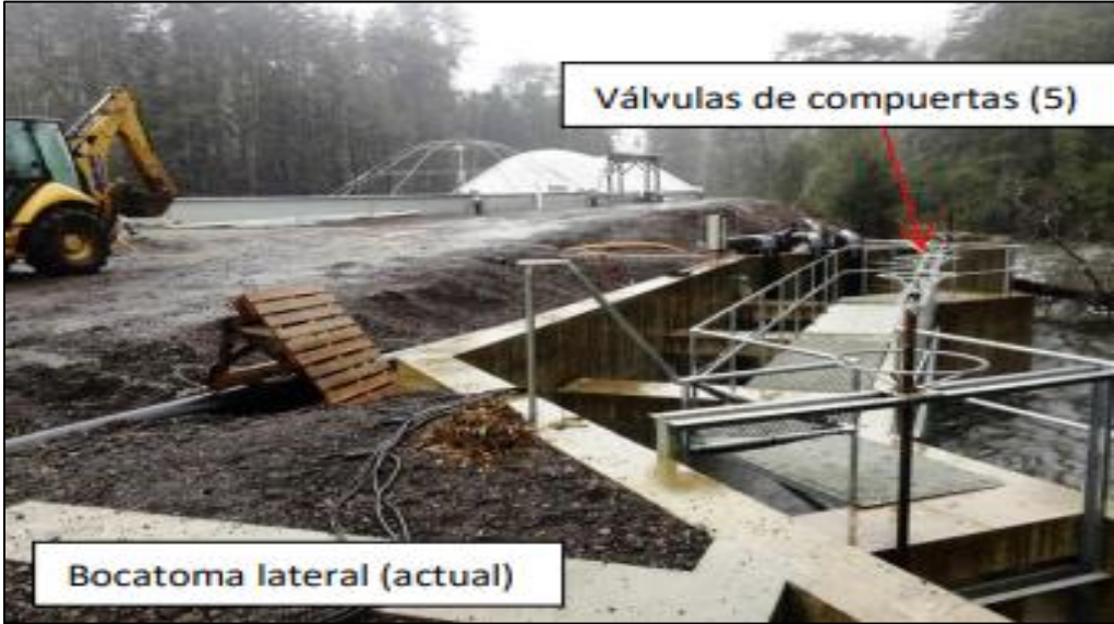
Imagen N° 2: Obra de captación de agua en el río Carhuello.
