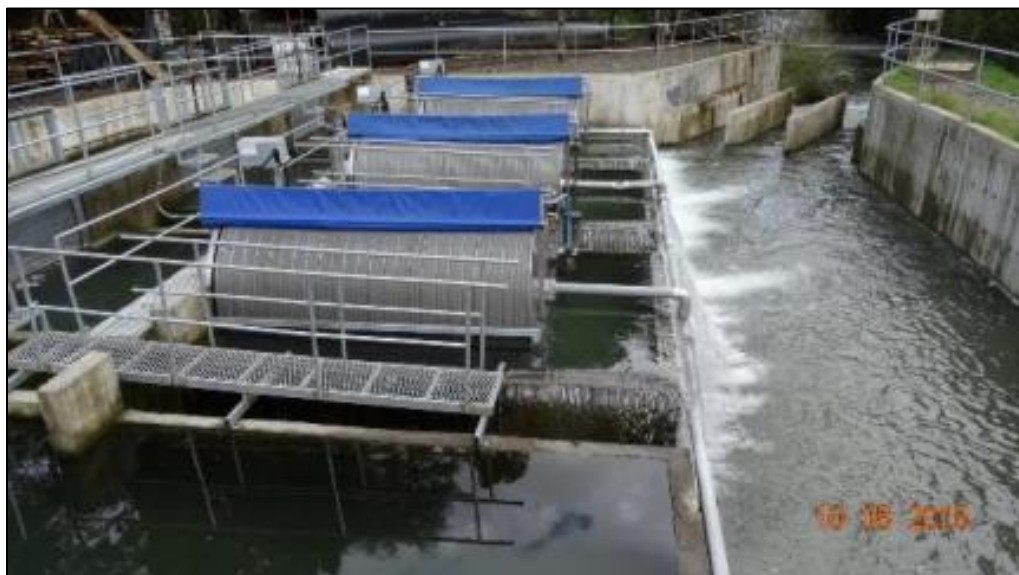
Imagen N° 12: Rotofiltros y obra de descarga del efluente tratado en río Carhuello.
