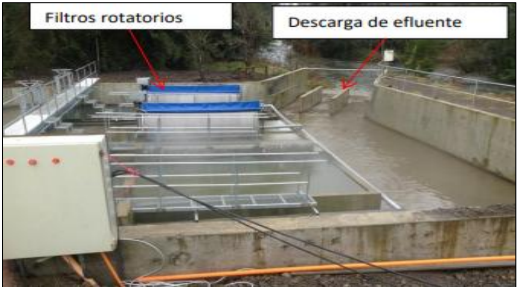
Imagen N° 4: Sistema de filtros rotatorios y canal de descarga del efluente tratado.
