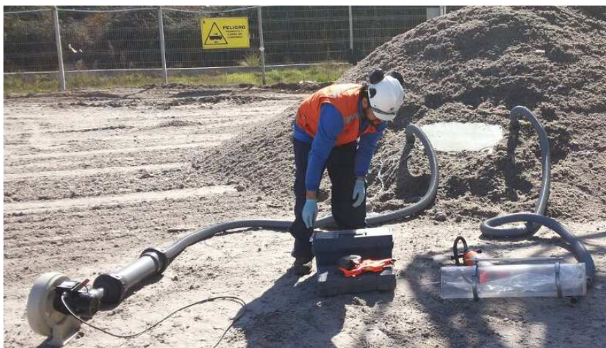
Figura 8 (*) : Unión tubos corrugado de PVC
