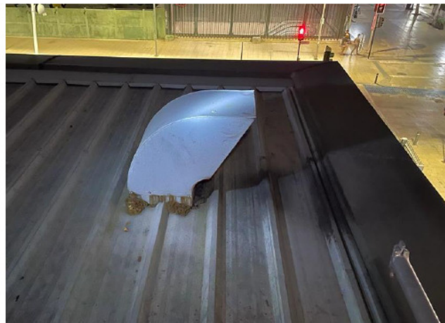
Imagen 3. Extremo ducto sobre cubierta edículo ascensor
