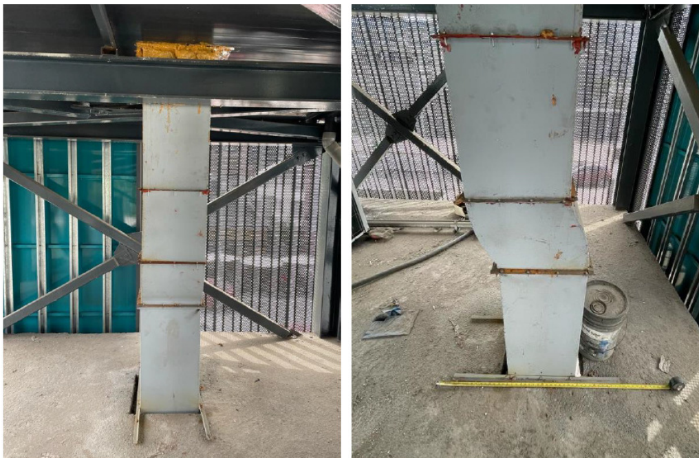
Imagen 7. Ducto vertical en el pasillo técnico
