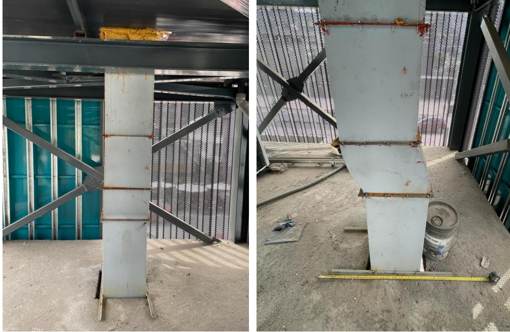
Ducto vertical en interior pasillo técnico edículo ascensor
