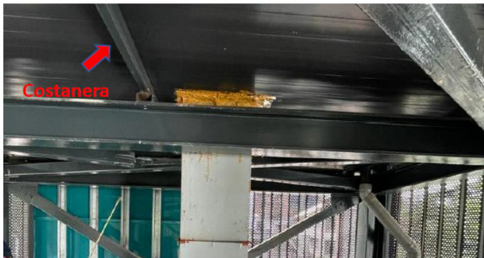
Imagen 6. Condición actual de la estructura metálica que soporta la cubierta
