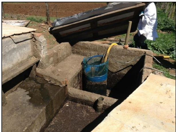
Figura N° 7. Bomba sumergida que extrae e impulsa el Ril hacia el área de riego
