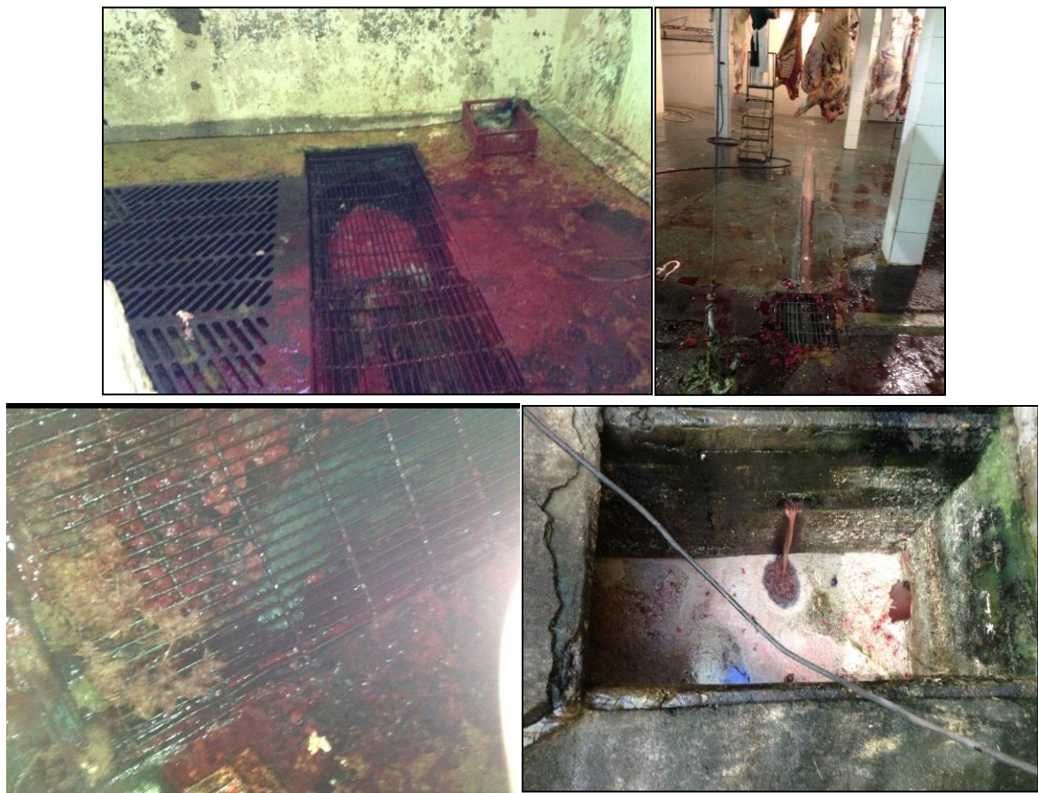
Figura N° 2. Cámaras de captación de sangre y restos orgánicos dentro de la zona de matanza
