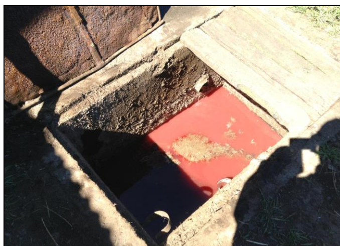
Figura N° 4. Cámara común, que recepciona los afluentes de las diversas cámaras del sistema.
