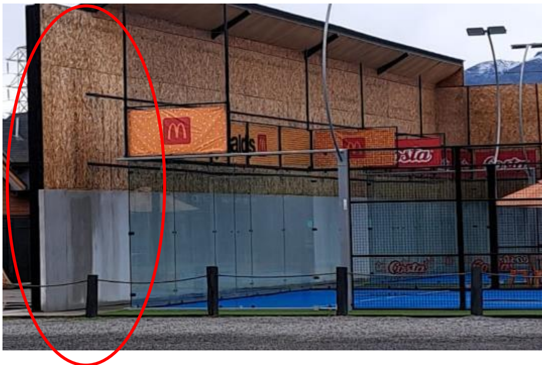
Fotografía 6: Se aprecia claramente la sobrecarga de aguas lluvias que tiene el muro por no tener el material de revestimiento adecuado y no estar con la adecuada cumbrera en el extremo Oeste.
