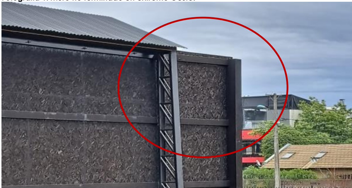
Fotografía 1: Muro no terminado en extremo Oeste.
