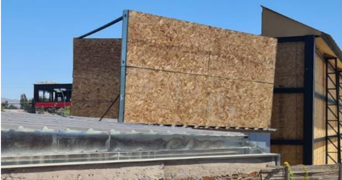
Fotografía 9: Se aprecia que las fijaciones no son adecuadas lo que conlleva un peligro constante de voladura. Además de no poseer cumbrera en ninguna de sus costados.
