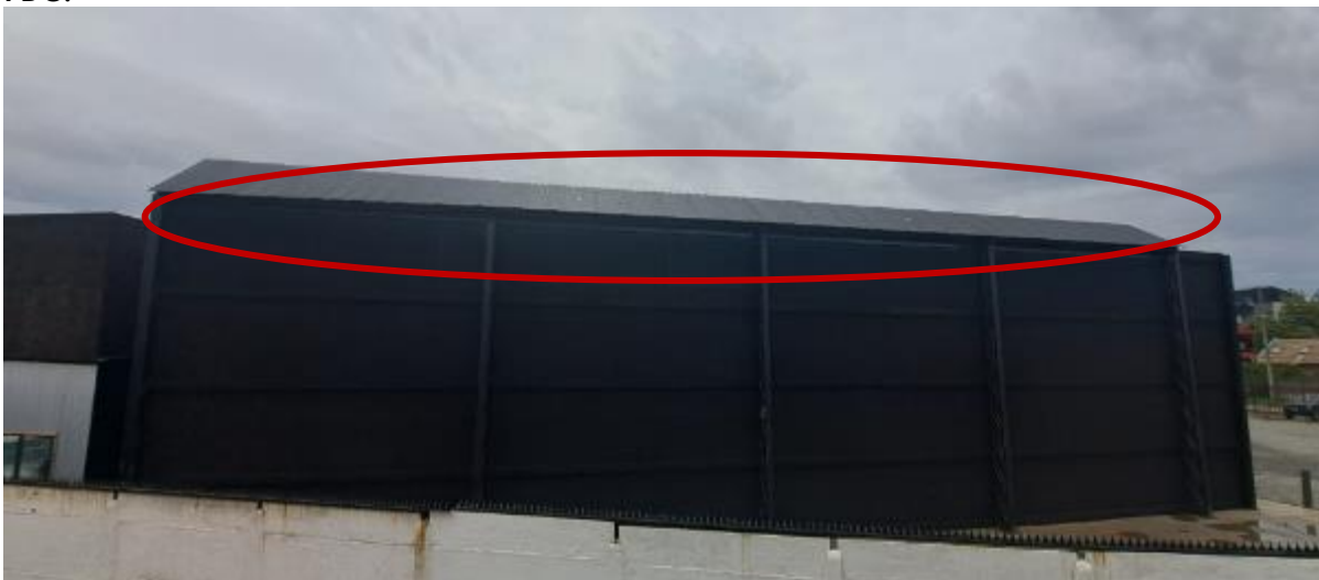
Fotografía 3: Se aprecia que el muro no tiene la cumbrera de acuerdo a lo presentado en PDC.
