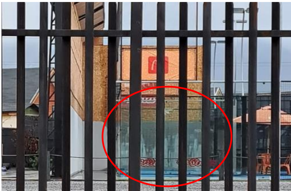
Fotografía 6: Se aprecia claramente la sobrecarga de aguas lluvias que tiene el muro por no tener el material de revestimiento adecuado y no estar con la adecuada cumbrera en el extremo Oeste.
