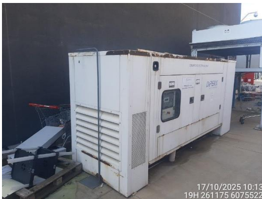
Generador eléctrico (emergencia, sin funcionamiento)
