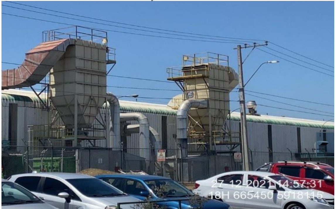
Imagen N°2. Situación Filtros de Aire Líneas Melamina 1 y 2, a diciembre de 2021, fechada y con coordenadas.
