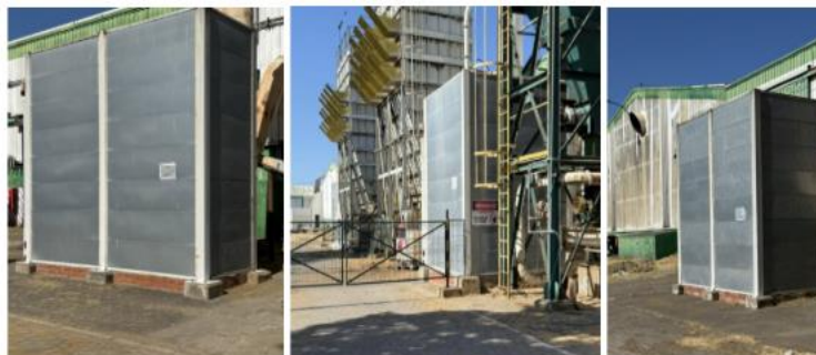
Imagen N°4. Encapsulamiento Ventiladores de aspiraciones de Nave Productos Terminados y bodega de producción.
