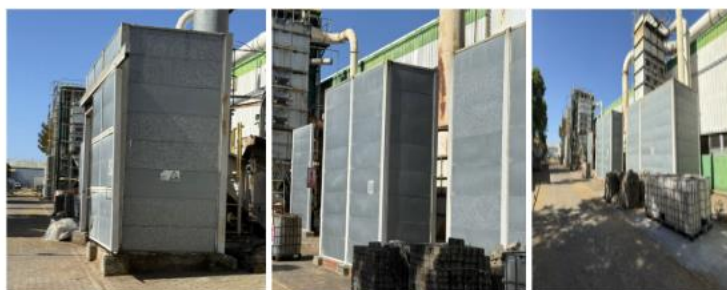
Imagen N°3. Encapsulamiento Ventiladores de aspiraciones de Nave Productos Terminados y bodega de producción.
