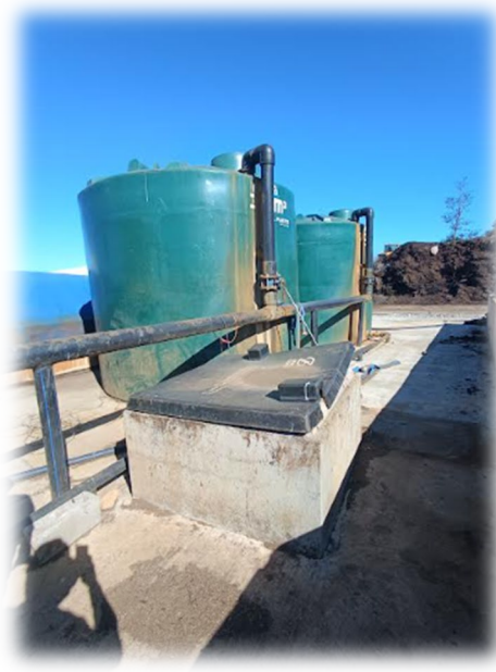
Imagen 6 Estanques de acumulación de lixiviados
