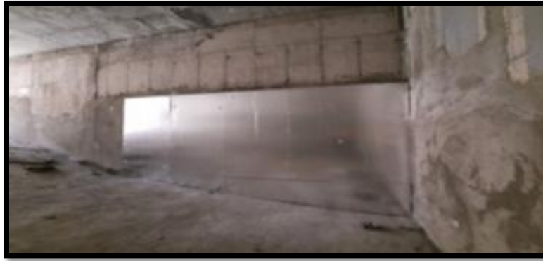
[Imagen N° 1: Fotografía donde consta la instalación de contención acústica en el nivel -2, aleñado a la sala del generador de ventilación]
