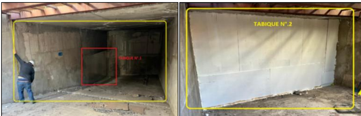
[Imagen N° 2: En rojo sector donde se instaló la primera contención acústica, y que corresponde a la Imagen N° 1, en amarillo la segunda contención, sellando totalmente el túnel]
