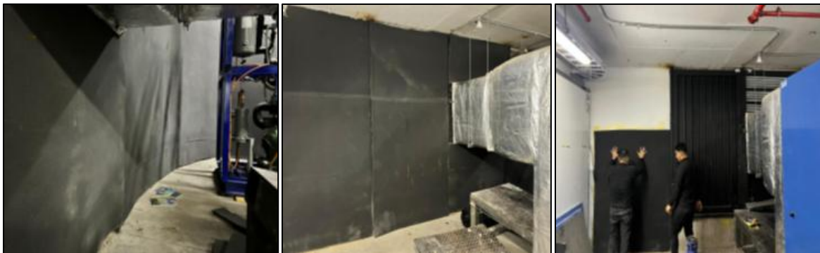
[Imagen N° 4: Fotografías donde consta la instalación de espuma acústica -elemento negro que se observar en las imágenes- en las paredes de la sala del generador]
