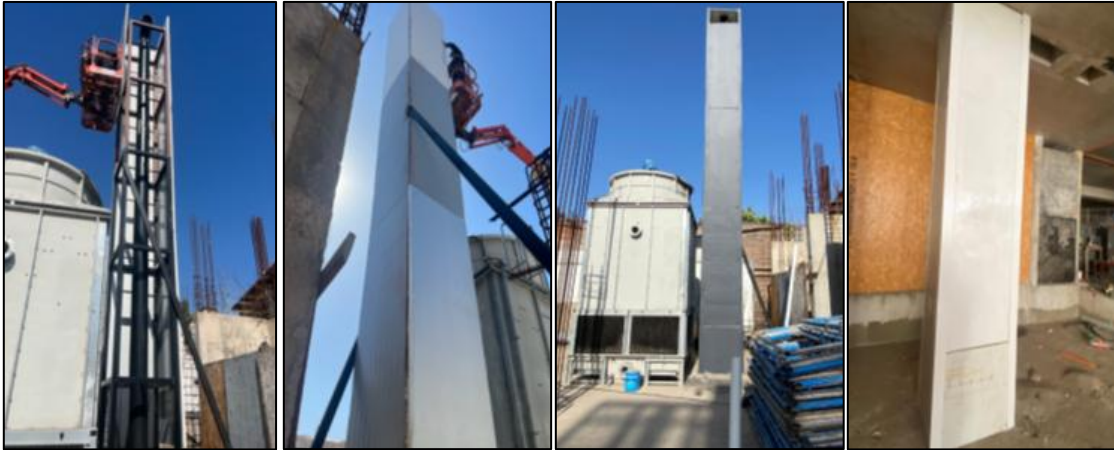
[Imagen N° 3: Fotografías donde consta la instalación de revestimiento acústico al ducto de escape del generador. En la primera imagen se observa el escape sin revestimiento, en las siguientes se observa éste ya instalado]
