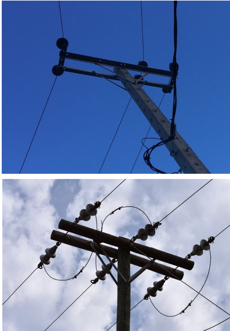
Fotografía 4. Tipo de postes del Tendido Eléctrico con mayor frecuencia de registro de rapaces muertas. Transversal sin puentes (arriba) y transversal con puentes (abajo).
