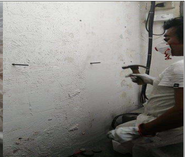
Instalación de fierro de 6mm
