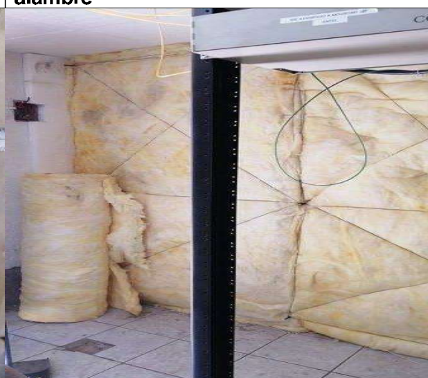
Vista trabajo terminado
