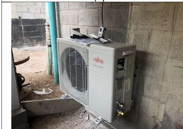
Instalacion de unidad condensadora
