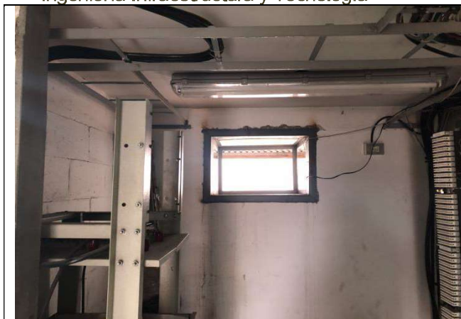
Retiro de equipo ventana
