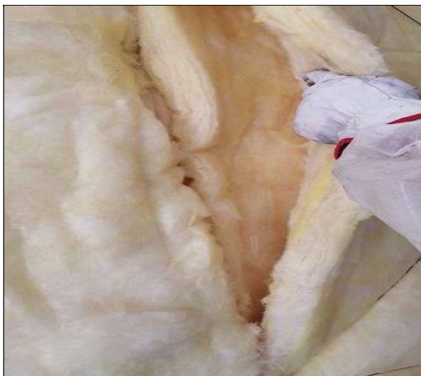
Doble lana mineral instalada
