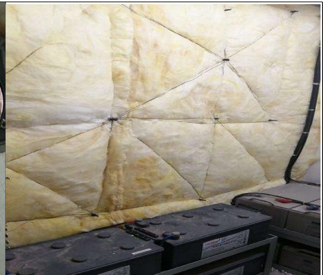
Vista trabajo terminado
