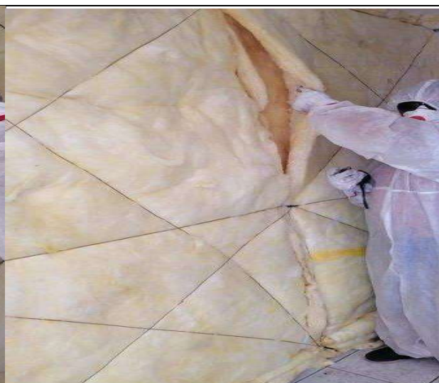
Lana mineral afianzada al muro con alambre
