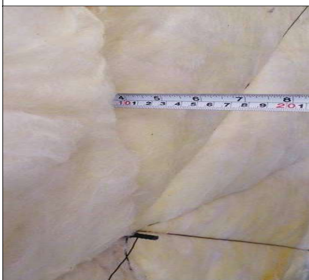
Espesor logrado de lana mineral,10cm
