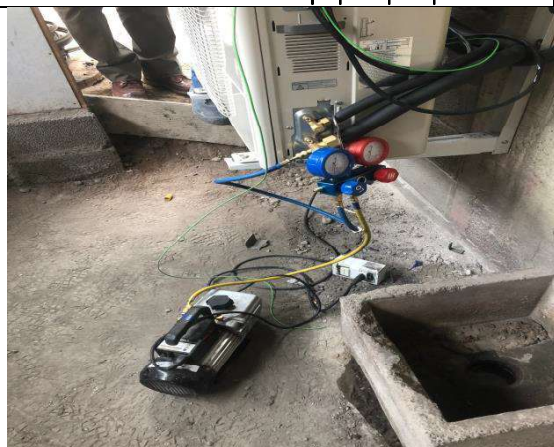
Vacío de circuito de refrigeración
