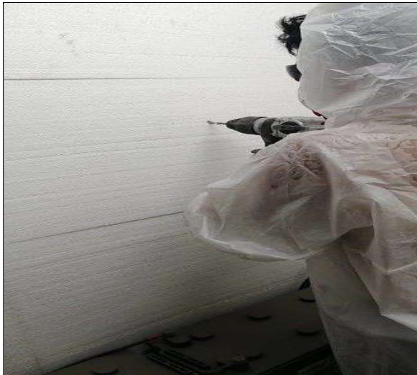
Perforando el muro
