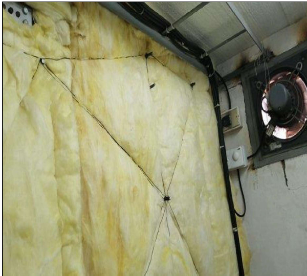
Vista trabajo terminado
