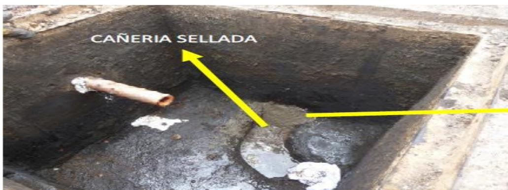
**Foto N° 11:** Sello de tubería de alcantarillado que unía sistema de recirculación de los Calentadores Electrolitos
