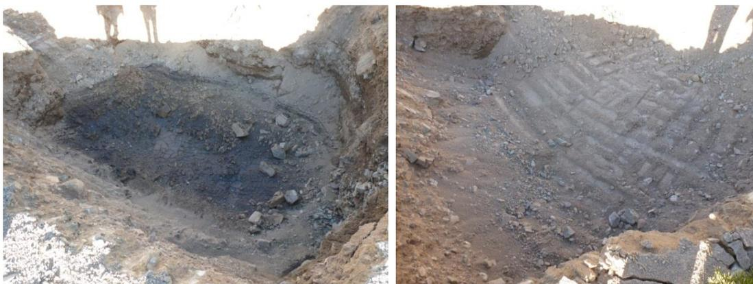
**Foto N° 9:** Se confeccionan dos calicatas con capacidad de 6 m<sup>3</sup> cada una.
