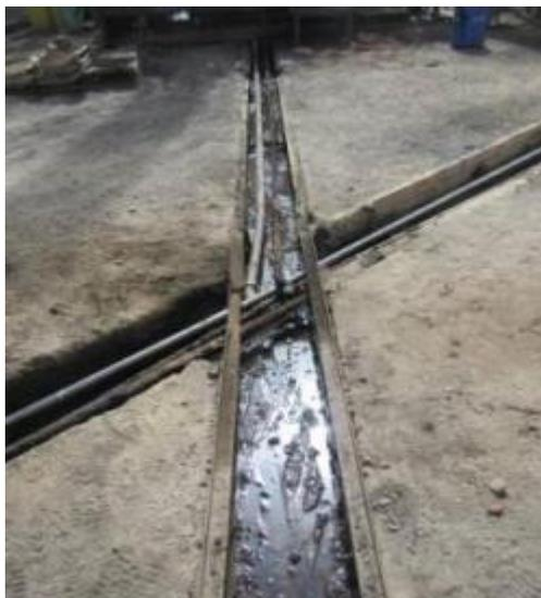
**Foto N°1:** Canaletas contaminadas con Fuel Oil N° 6
