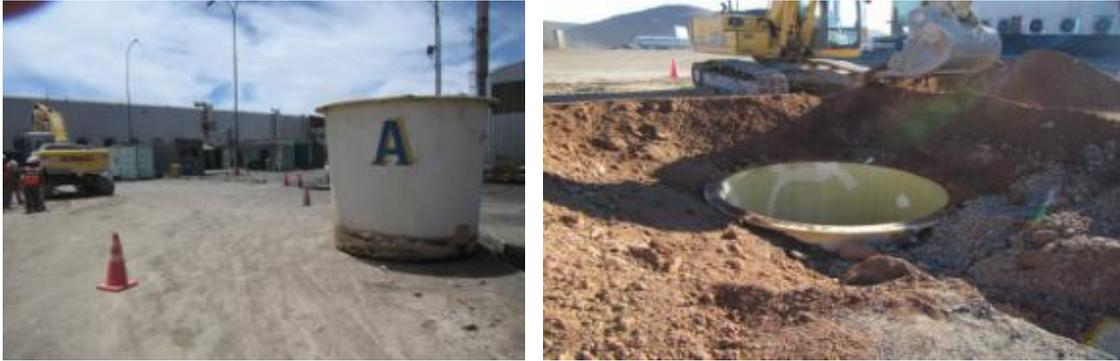
**Foto N°12:** Instalación de estanque de contención.
