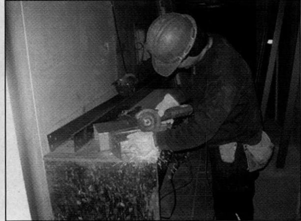
**Imagen 2.** Ejecución de faenas de corte con sierra circular en subterráneo de edificio.
