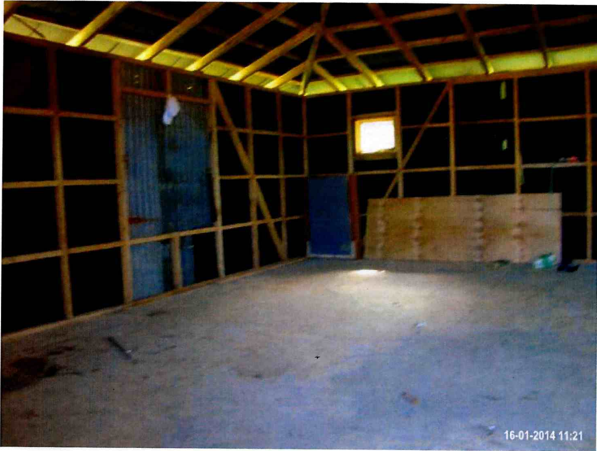
Fotografía N° 12: WP 170, Coordenadas correspondientes al interior de la Bodega, esquina Noreste.
