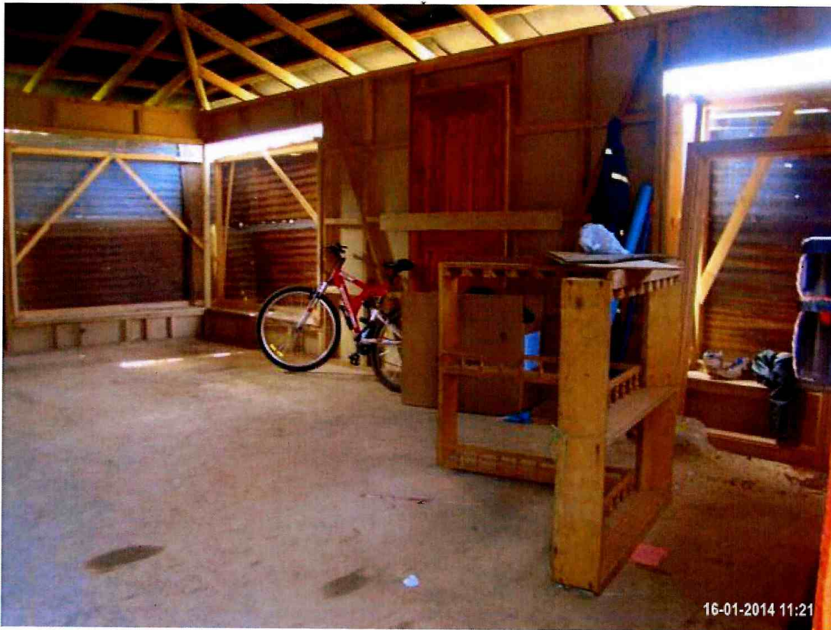
Fotografía N°11, WP 171, Coordenadas correspondientes al interior de la Bodega, esquina Sur este.
