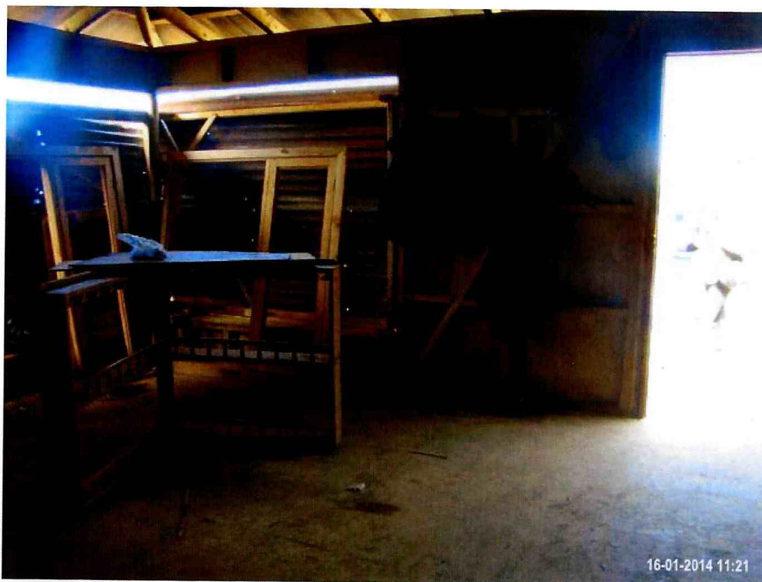
Fotografía N°13: WP 169, Coordenadas correspondientes al interior de la Bodega, esquina Sur oeste.
