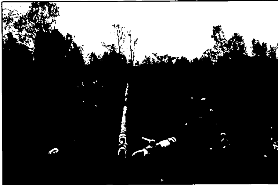
Fotografía N° 1: Hidrantes conectados a una submatriz soterrada del sistema de riego
