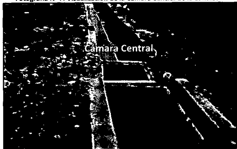
Fotografía N° 7: Visualización de la Cámara Central de la Canaleta
