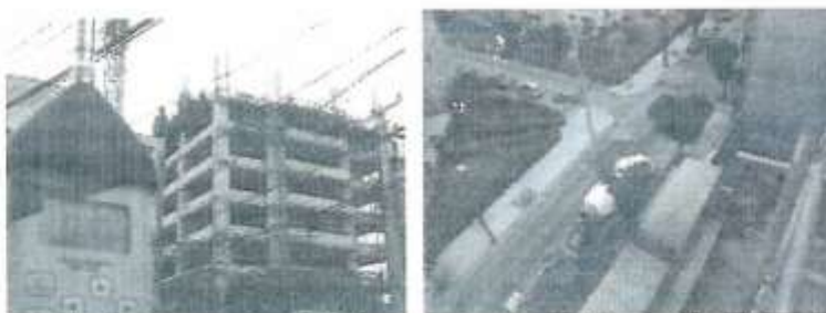
Fotografías: (Izq.) Edificio Janequeo y medición en un punto receptor. (der.) Vista desde el edificio al punto receptor identificado con un punto rojo.
