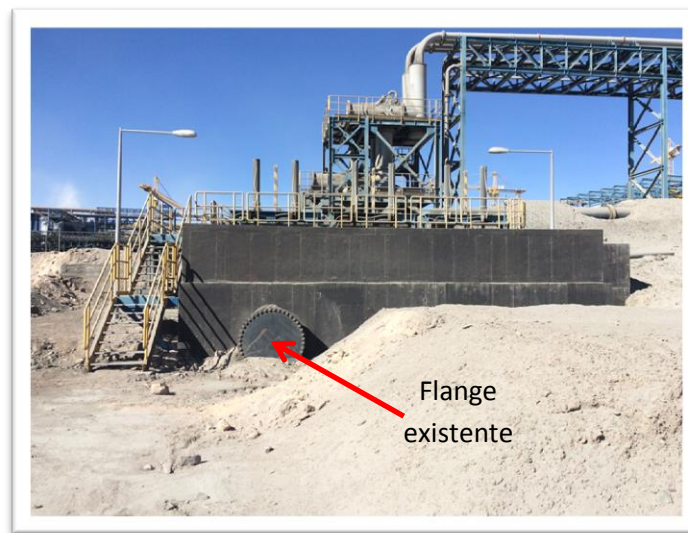
Figura 5: Conexión a Cajón de Inicio.
