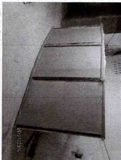
Pantalla acústica tipo biombo en primer piso, torre C.
