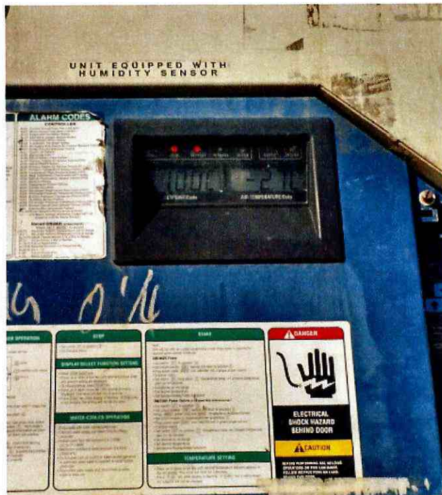
Visor equipo de frio Reeffer (seteo -10^{\circ}\text{C} )
