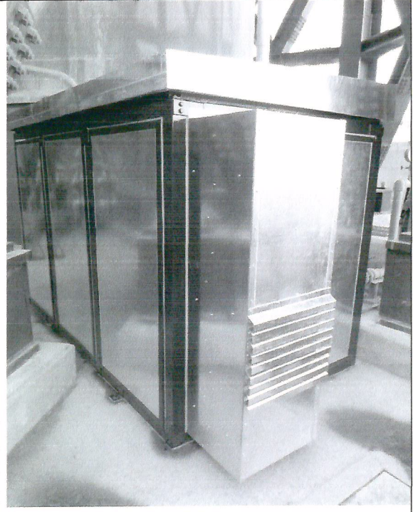
Encierro Acústico Fabricado para Planta Bocamina ENDESA S.A.
