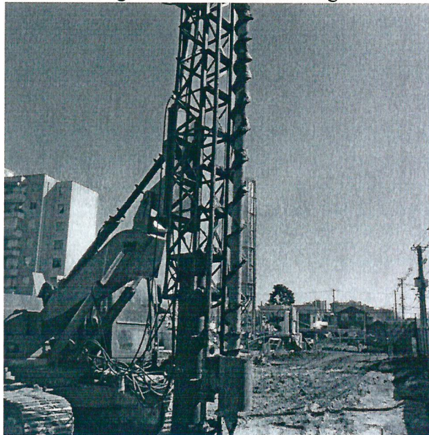
Fotografía N°3 “Barreno Auger”
