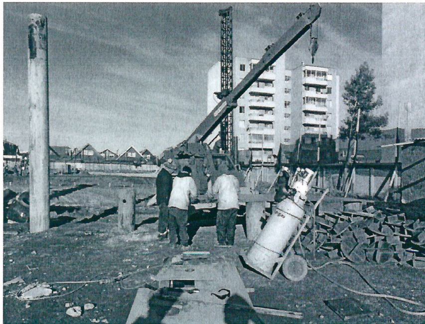
Fotografía N°5 “ Grúa de Apoyo para Izaje de Biombo Acustico”
