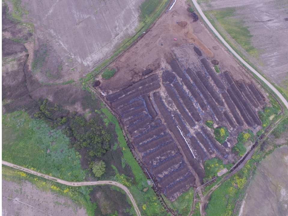
Imagen 1 y 2: Fotografías aéreas Sitio de Acopio de GAC, donde se aprecian zanjas perimetrales
