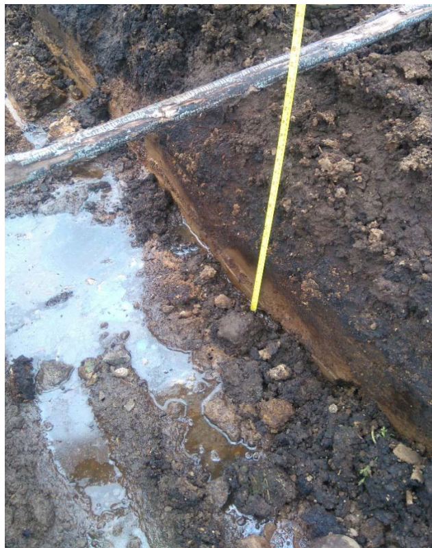
Imagen 4: Fotografía zanja perimetral con huincha de medición de profundidad
