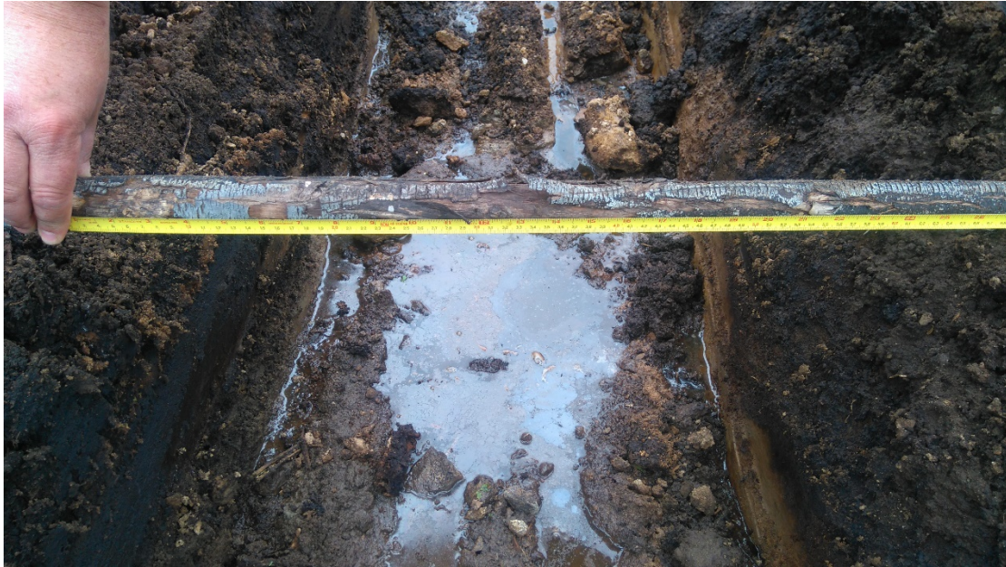
Imagen 3: Fotografía zanja perimetral con huincha de medición de ancho
