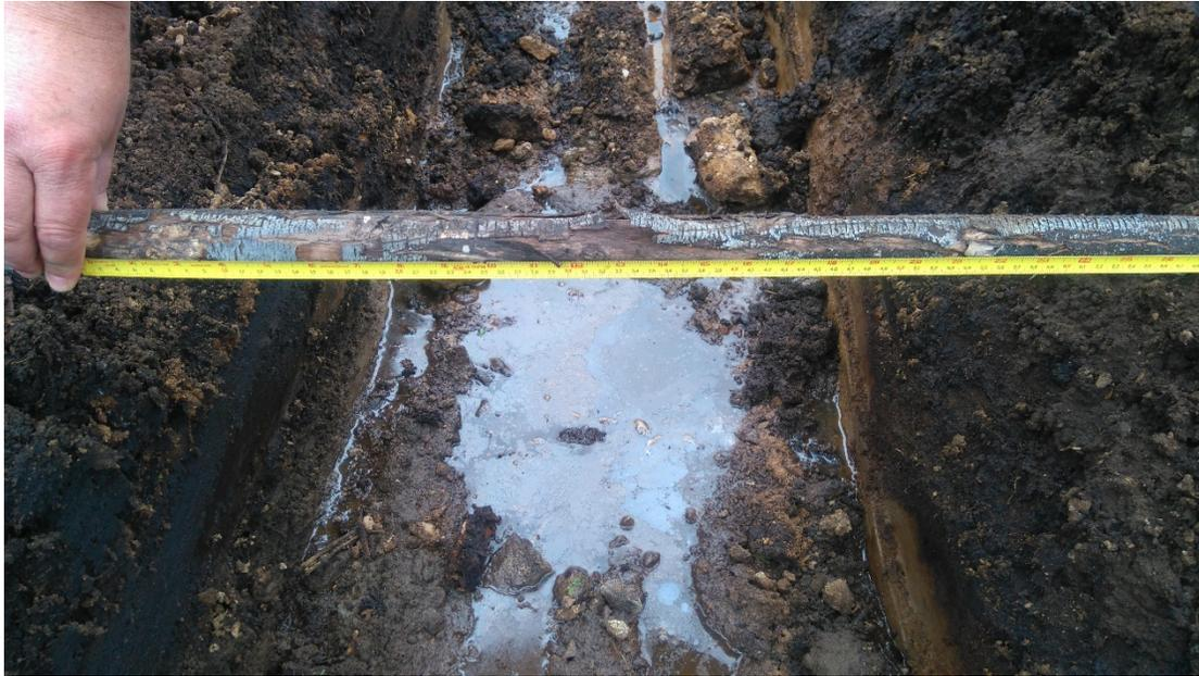
**Imagen 4: Fotografía zanja perimetral con huincha de medición de profundidad**
