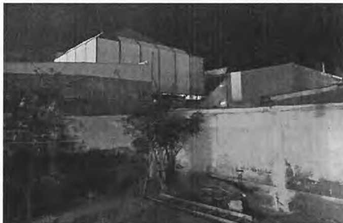
Figura 2. Aislamiento acústico finalizado.
