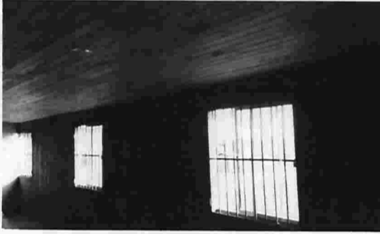
Revestimiento Interior Segundo Nivel
