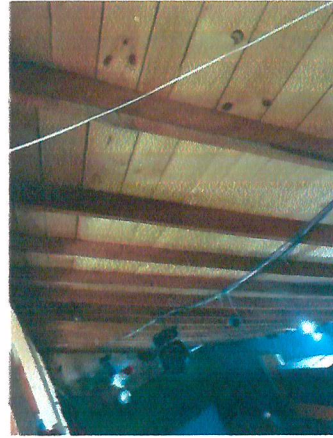
Techumbre "Salón de Baile"
