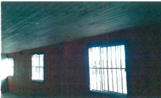
Revestimiento Interior Segundo Nivel
