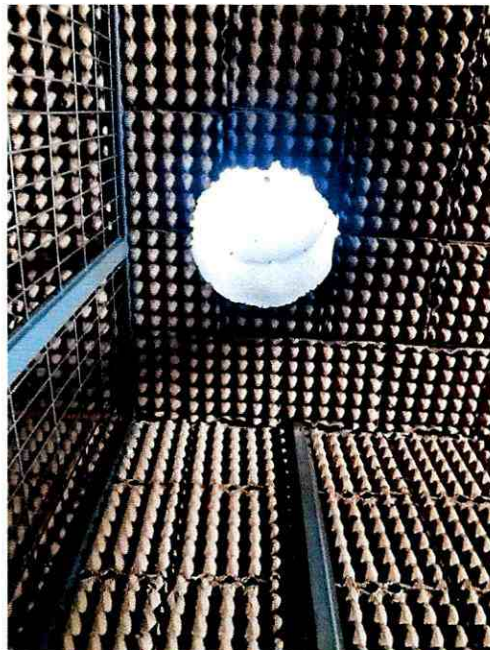
Imagen 6: Sala Grupo Electrónico - Ventilación Ubicación: 339696 E, 6296438 N
