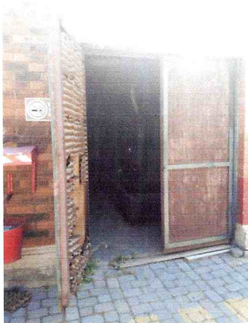
Imagen 5: Sala Grupo Electrónico – Puertas exterior Ubicación: 339696 E, 6296438 N
