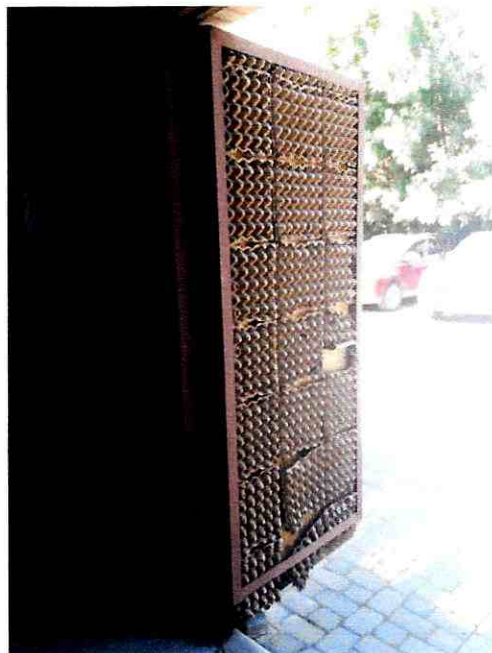
Imagen 6: Sala Grupo Electrónico – Puertas interior Ubicación: 339696 E, 6296438 N
