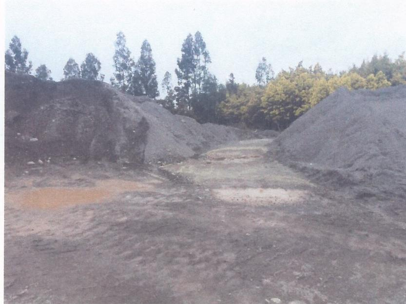
Muro ya hecho se aprecia entre puntos M y A tiene 110 metros de largo y 6 metros de altura.
