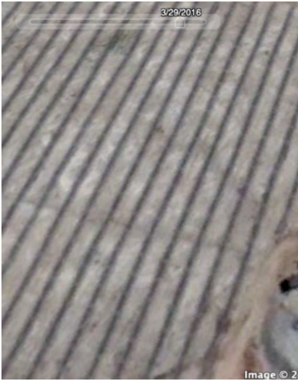
Año: 2016 – Piscina de Evaporación parcialmente tapada
