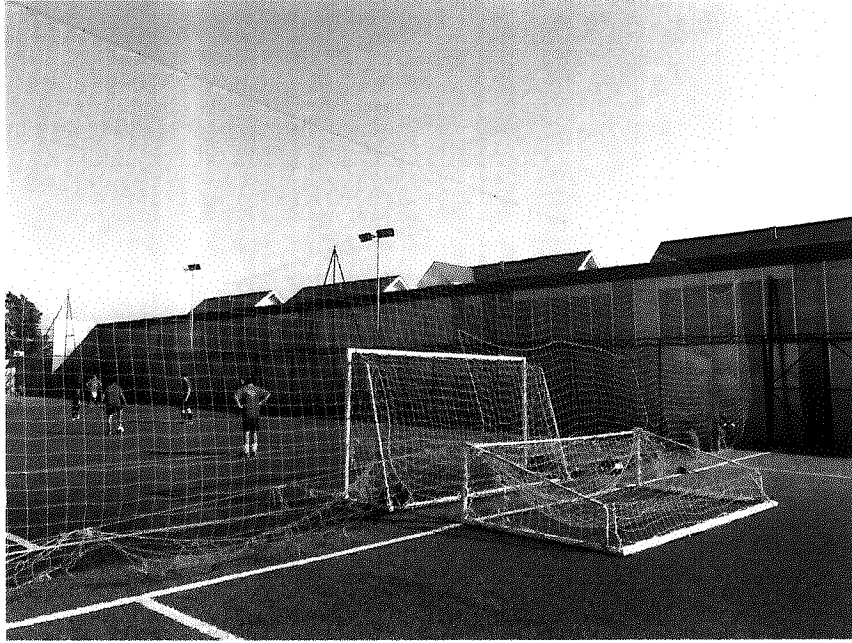
Fig. 15: Fotografía de pantalla acústica instalada en multicancha.
