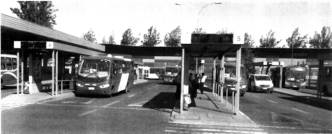
Fig. 14: Fotografía de pantalla acústica pintada instalada en terminal de buses.
