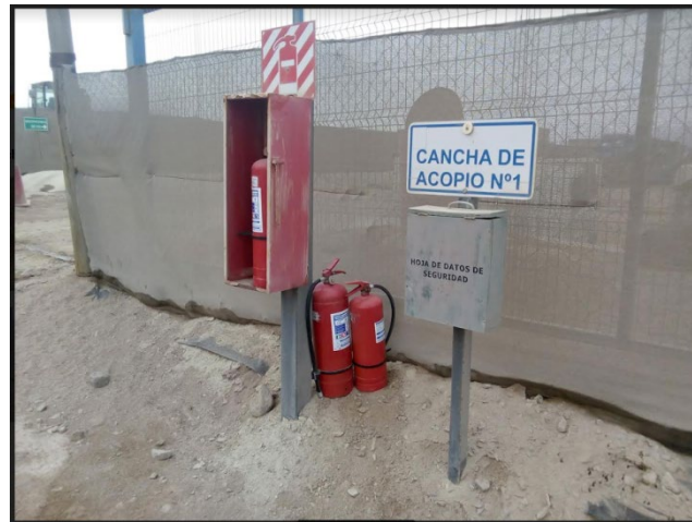
Fotografía 1: equipos de extinción de incendios cancha de acopio N°1 ubicación datum WGS 84 huso 19 361615E 6959121N, Fotografía 11 de diciembre del 2018.
