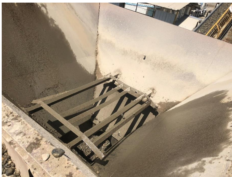
Figura 11. Sistema de recepción de ripio (Ready mix).
