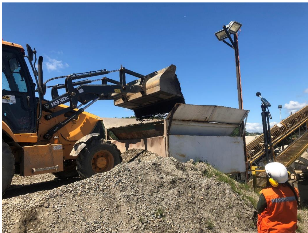
Figura 10. Descarga de ripio (Ready mix).
