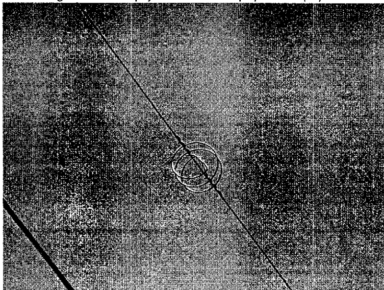
Fotografía 1: Salva pájaros en tramo Apoyo N°9- Apoyo N°10
